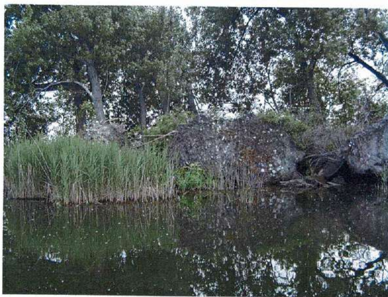
Dissesti dovuti al sovraccarico arboreo delle briglie
